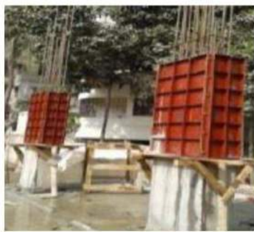
স্টীল ফ্রেম ফর্মওয়ার্ক সিস্টেম
