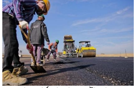
রোডওয়ার্ক বা রোড কম্পট্রাকশন
