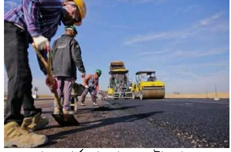
রোডওয়ার্ক বা রোড কম্পট্রাকশন
