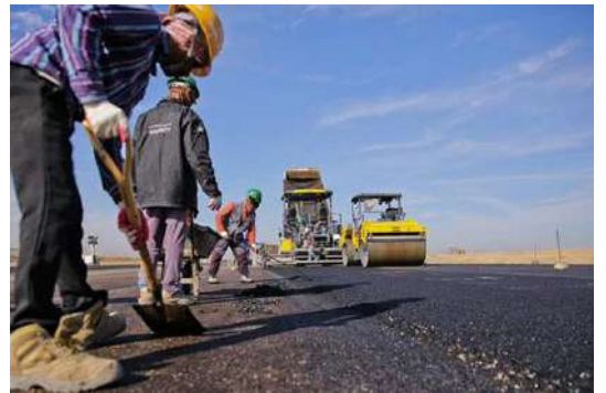
রোডওয়ার্ক বা রোড কন্সট্রাকশন
