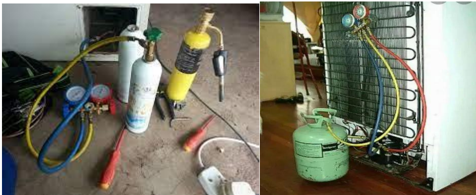
চিত্রঃ রেফ্রিজারেটর এবং ফ্রিজারে রেফ্রিজারেন্ট চার্জ করা
